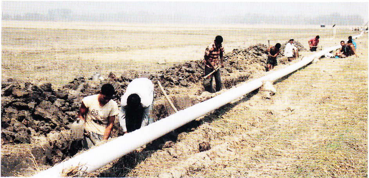
কোম্পানীর নবীগঞ্জ গ্যাস সরবরাহ ও বিতরণ প্রকল্পের অধীনে উচ্চচাপ পাইপলাইন নির্মাণ কাজ
